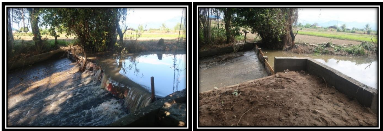
๑๒.๓ ปรับปรุง/ซ่อมแซมฝายริน หมู่ ๒
