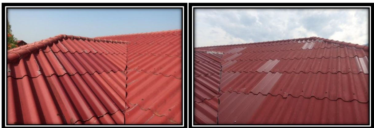
๑๒.๔ปรับปรุง/ซ่อมแซมหลังคาศูนย์พัฒนาเด็กเล็ก
